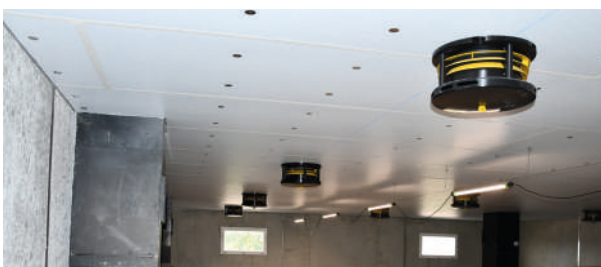
Installation sur panneaux mousse PU
